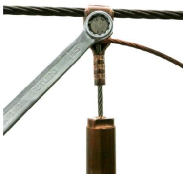
2. Fissare il morsetto alla fune portante. Stringere i bulloni con chiave dinamometrica a 25 Nm.
