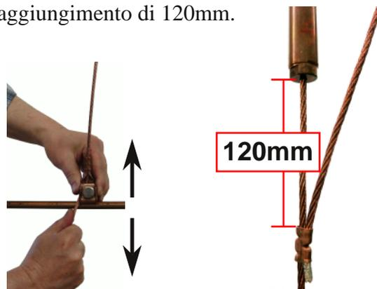
5. Fissare il morsetto definitivamente al filo di contatto. Stringere i bulloni con chiave dinamometrica a 25 Nm.
