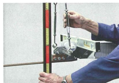
11. Monter les patins et aligner les avec un niveau à bulle d'air en parallèle de la voie et à la hauteur inférieure du fil de contact. Serrer les écrous légèrement.
