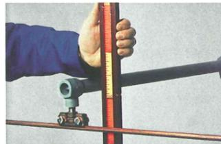
**Remarque:** Pour déterminer exactement la valeur de la surélévation du sectionneur (cote x), le fil de contact peut être surélevé à l'endroit du montage au moyen d'un dynamomètre avec une force de 120 – 150 N. La surélévation ainsi obtenue du fil de contact correspond à la surélévation optimale du sectionneur (cote x).
