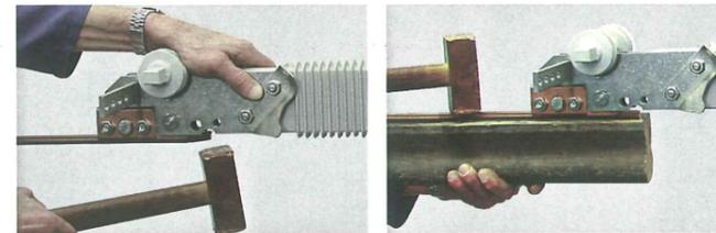
Monter la suspension. Les suspensions doivent être montées verticalement à  $\pm 5^\circ$  par rapport au sens de circulation. Ajuster la hauteur du sectionneur à la valeur plus haute de la cote x (si pas connue 40 mm) que celle calculée sous le point 4. Pour cela, soulever d'abord le sectionneur et régler en gros la hauteur au moyen des suspensions.
