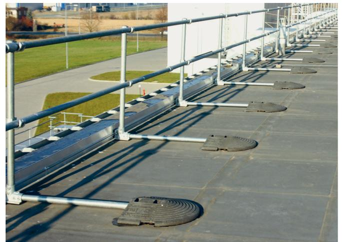
Abb. 16: Ausstattungsstufe 3: Seitenschutzsystem mit Auflast
