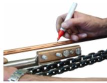
3. Fahrdrabt zwischen den beiden Markierungen herausschneiden. Flaschenzug spannen bis die Fahrdrabtlücke der des Isolators entspricht. Fahrdrabtenenden richten.
